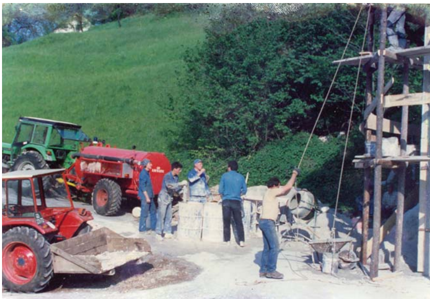
Gradnja gasilskega doma v Zavrattcu leta 1986.
