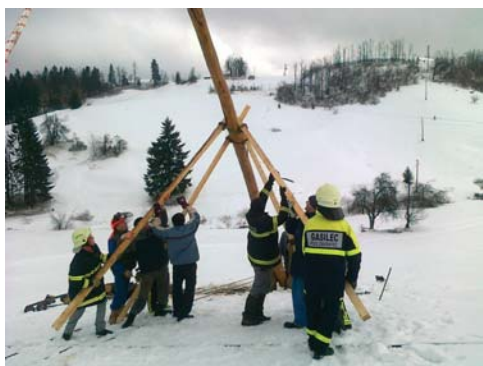
Postavljanje električnih drogov po žledolomu v Potoku.
