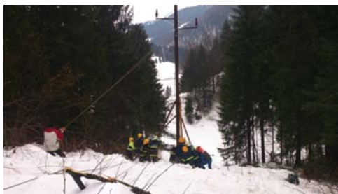
Postavljanje električnih drogov po žledolomu proti Brekovicam.
